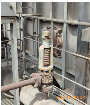
รูปที่ 2-44 Safety Valve ของหม้อไอน้ำ
