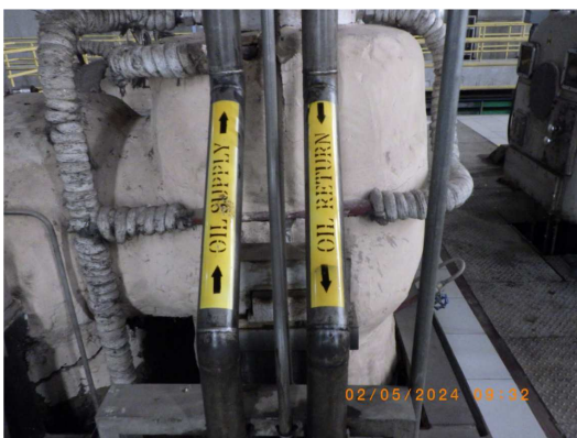
รูปที่ 2-56 ระบบท่อน้ำมันเลี้ยงแบร์ริง ของ Turbine & Generator
