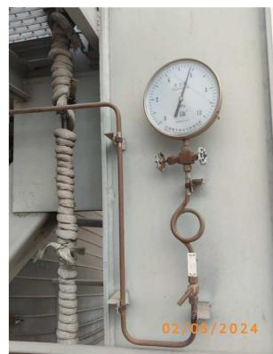
รูปที่ 2-45 Pressure gauge ของหม้อไอน้ำ
