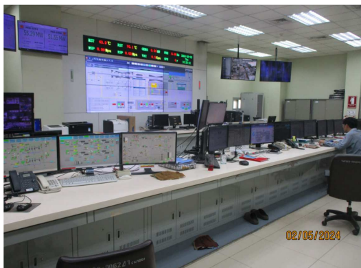
รูปที่ 2-7 แผงหน้าจอของระบบควบคุม การทำงานในห้องควบคุม
