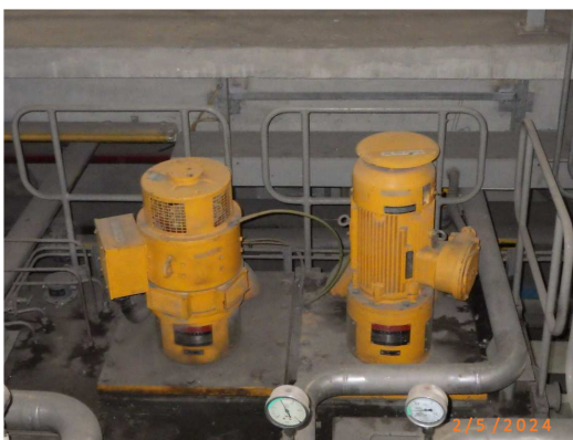
รูปที่ 2-57 การติดตั้ง DC Oil Pump ภายในโรงไฟฟ้า
