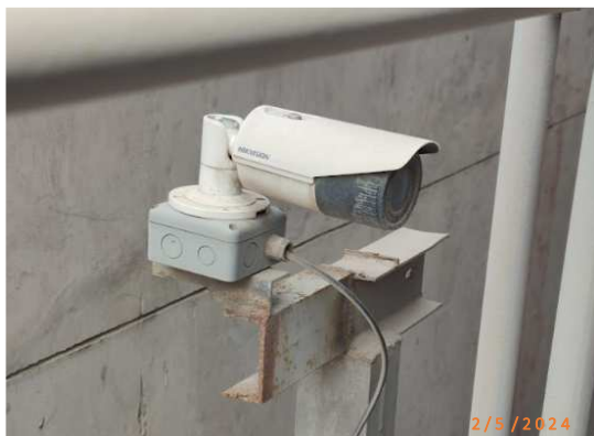
รูปที่ 2-48 การติดตั้งกล้องวงจรปิด สำหรับตรวจสอบระดับน้ำ ของหม้อไอน้ำ
