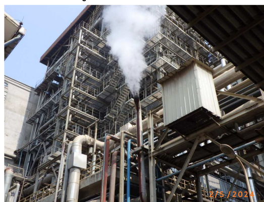
รูปที่ 2-41 อาคาร SP Boiler ที่มีทางเดินและบันได พร้อมราวกันตก
