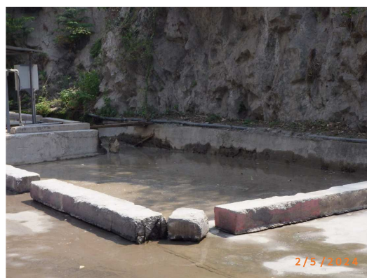
รูปที่ 2-12 บ่อพักน้ำ Blow Down ใต้ AQC Boiler
