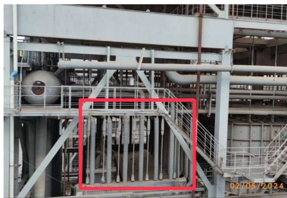
รูปที่ 2-47 Rapid Drain Piping System ของหม้อไอน้ำ
