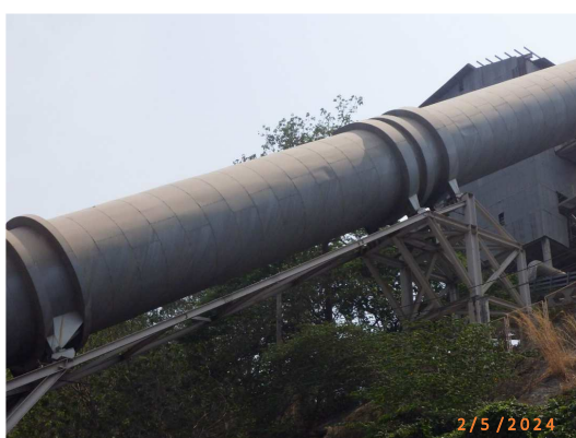
รูปที่ 2-52 ท่อลมร้อนที่ติดตั้ง Bypass Damper ของ AQC boiler
