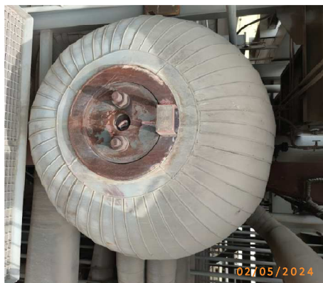
รูปที่ 2-43 Steam Drum ของหม้อไอน้ำ
